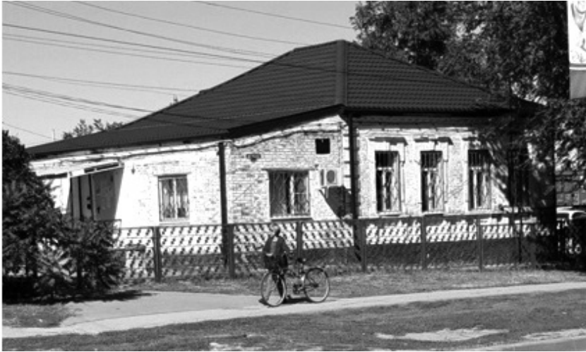
Дом на пересечении улиц Кирова и Парижской Коммуны, в котором во время оккупации находилось полицейское управление. Левая часть здания пристроена позднее. Под домом находится подвал размером 9,0 × 4,5 метров. В нём в период оккупации содержались заключённые
