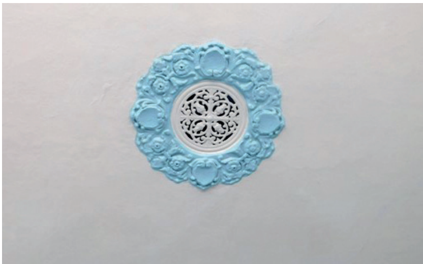
Фото 15. Вентиляция во втором зале ожидания тоже украшена орнаментом
