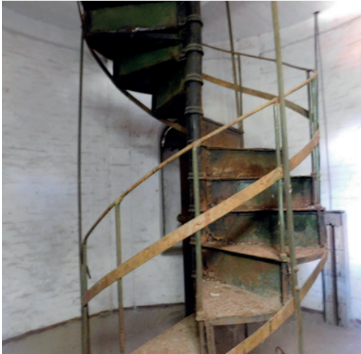
Фото 26. Вот так выглядит винтовая лестница внутри водонапорной башни
