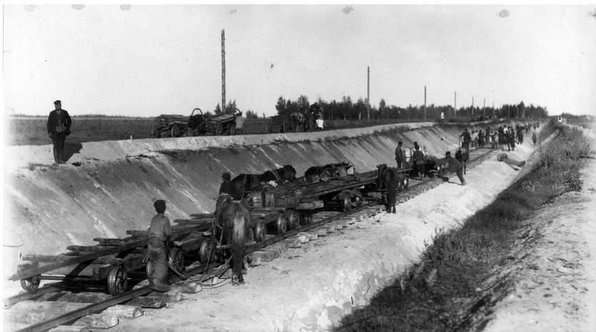
Фото 1. Идет укладка железнодорожного полотна
