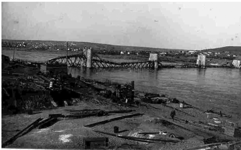
Разрушенный железнодорожный мост через р. Северский Донец у г. Белая Калитва
