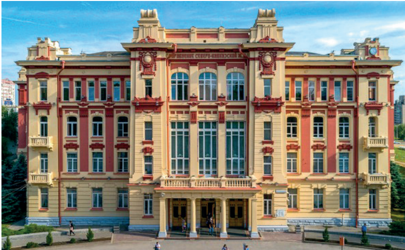
Фото 3. Здание Управления Владикавказской, ныне – Северо-Кавказской железной дороги
