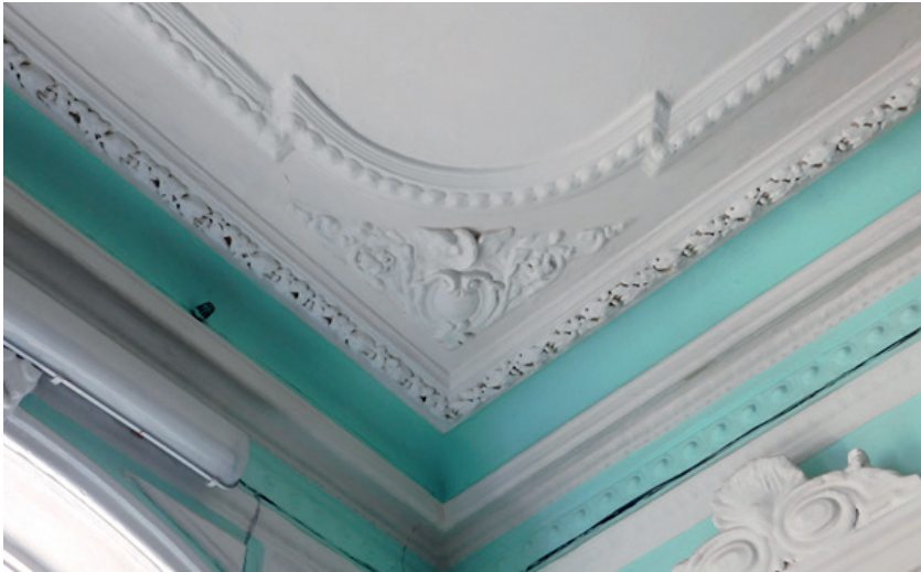
Фото 13. Потолок в зале ожидания первого класса, по всему периметру покрыт ажурным орнаментом
