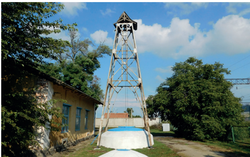
Фото 2. Скважина 1910 г., здесь же, под землей, находится четыре резервуара для отстоя воды
