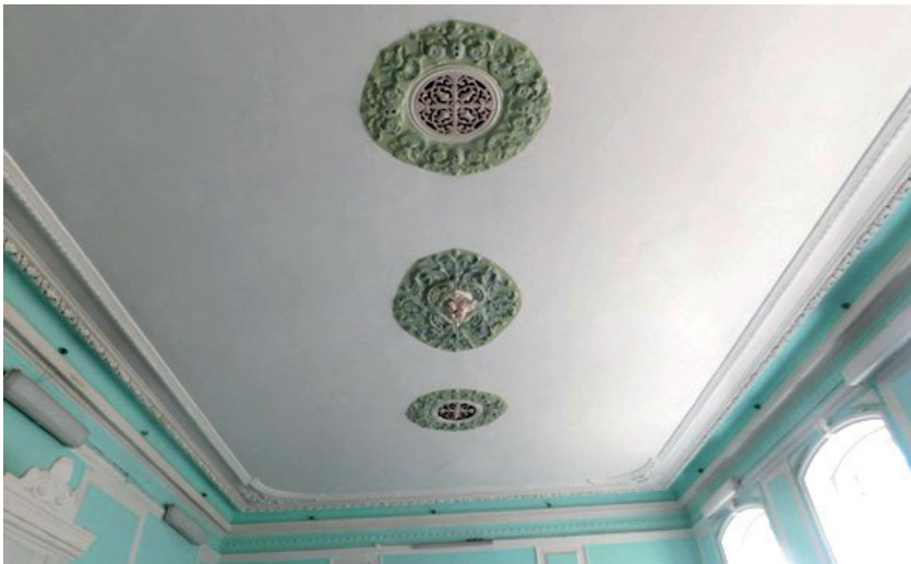
Фото 14. Два вентиляционных окна на потолке обрамлены «розетками» из лепнины, в середине потолка располагается «медальон» из лепки с крюком под люстру
