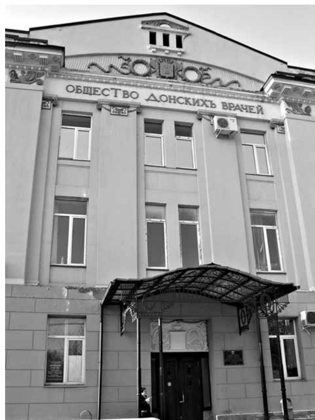
Фрагмент фасада больницы Общества донских врачей, главный вход. Фото Е. В. Халдаева
