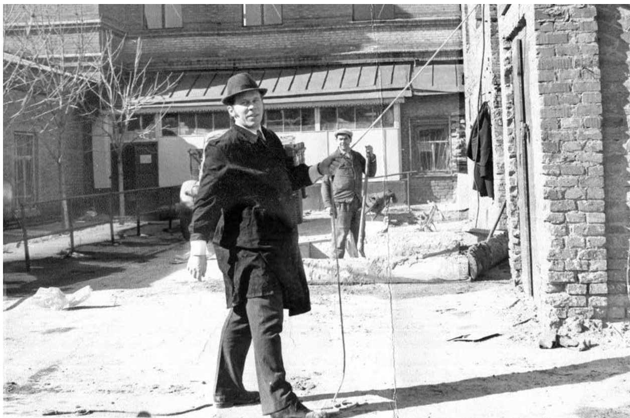
Внутренний двор будущего здания Азовского краеведческого музея. Директор музея А. А. Горбенко только-что отправил каменщику ведро с раствором. 1974 г. ОФ_31248-12
