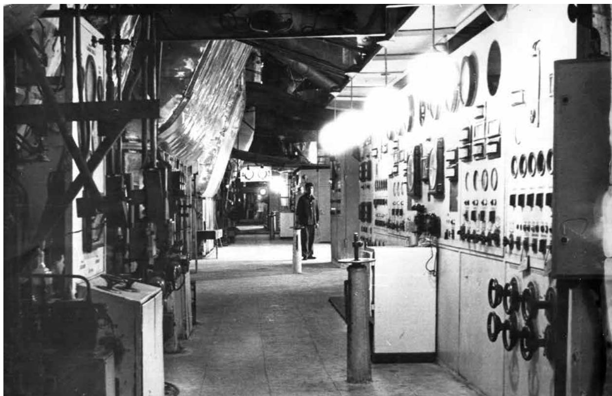
В цехе завода «Копнитель». 1980-е гг.
