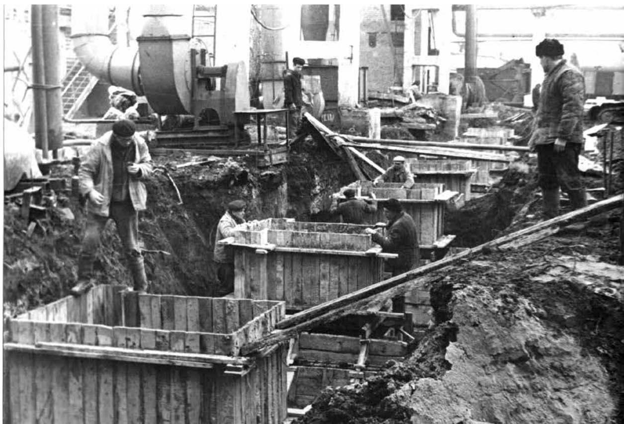
На строительной площадке № 3 ТЭЦ завода «Ростсельмаш». 1984 г.
