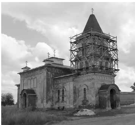
Церковь иконы Божией Матери Всех Скорбящих Радость в ходе реконструкции. с. Тихая Журавка, 2017 г. Фото Д. Д. Скорикова
