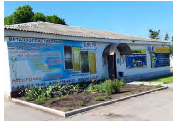
Фото 1. Здание бывшего молельного дома на улице Ленина
