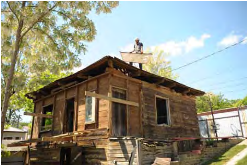
Разборка крыши куреня Поповых в Раздорской
