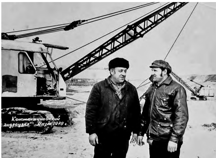
Строительство Константиновского гидроузла. 1979 г.
