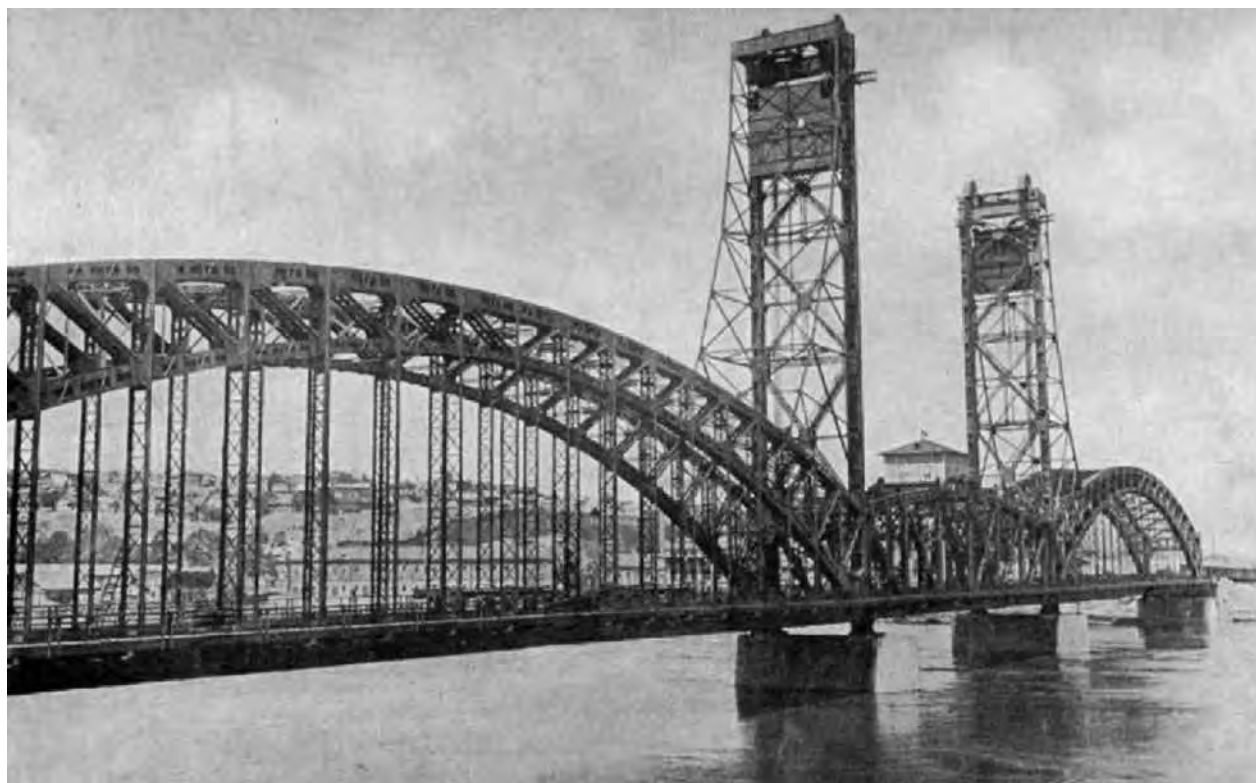
Разводной мост через р. Дон
