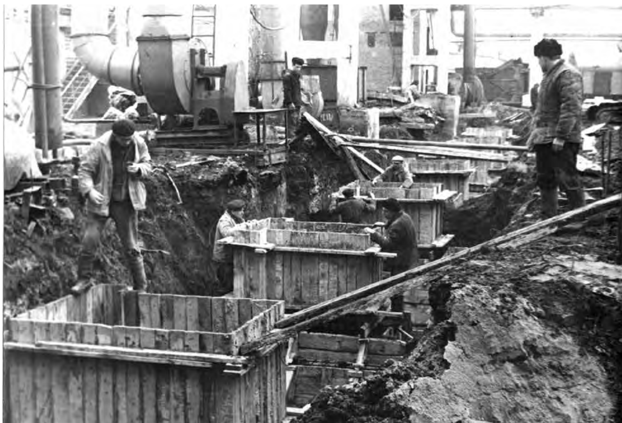
На строительной площадке № 3 ТЭЦ завода «Ростсельмаш». 1984 г.
